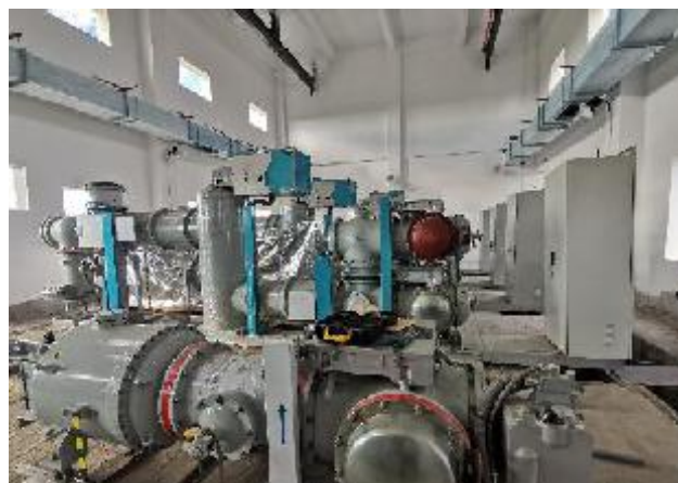
GIS буюу 110кВ-ын ХХБ-ын тоноглолын угсралт суурилуулалт
