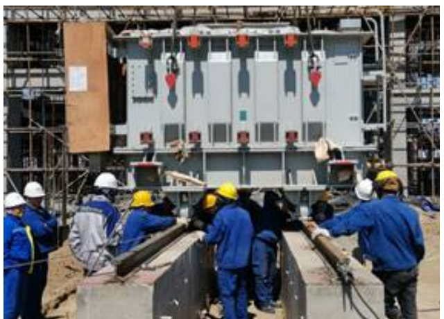
72МВа-ын үндсэн, 12.5МВа-ын бэлтгэл болон дотоод хэрэгцээний трансформаторын угсралт
