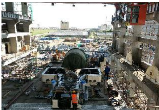
Генераторын угсралт суурилуулалт
