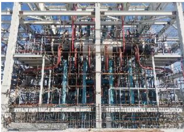
Зуухны тоноглолын угсралт суурилуулалт
