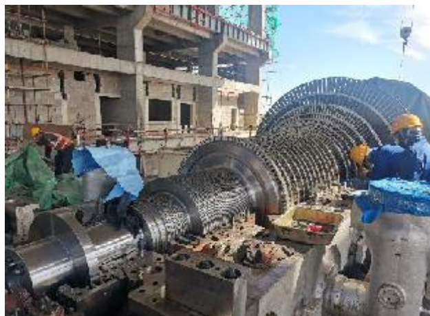
Уурын турбины угсралт суурилуулалт
