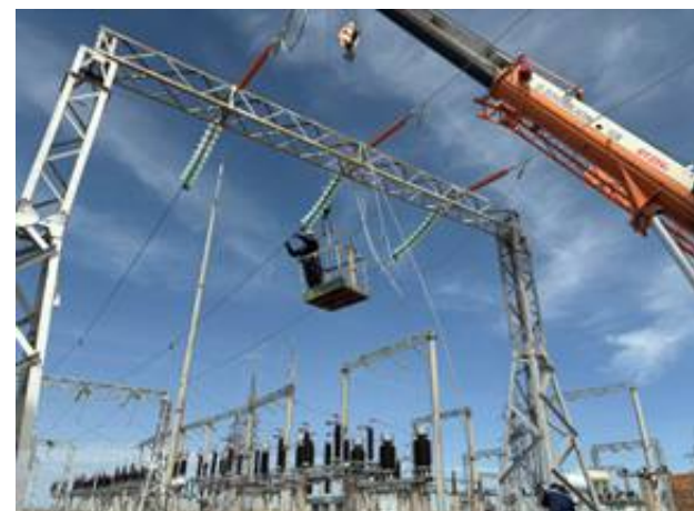
5.6 км урт 110кВ-ын ЦДАШ болон дэд станцын өргөтгөл
