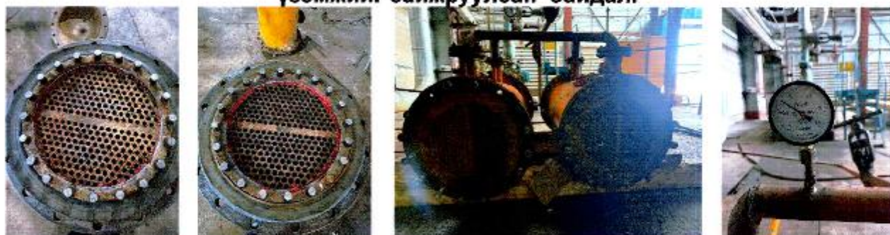
19. Турбины тос хөргөгч №1,2-ыг засварлаж зүрхэвчинд усан шахалт хийж будаж өнгө үзэмжийг сайжруулсан байдал.
