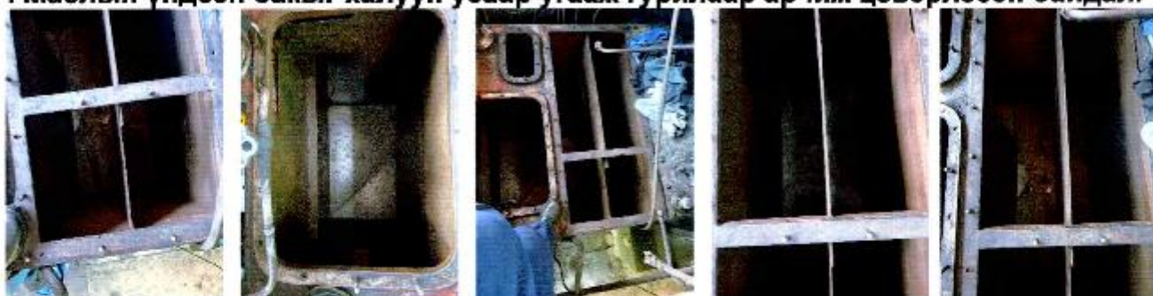
18. Турбины зогсоох клапангийн ууран талын том жижиг клапан, тос талын клапангууд тосны ф89мм-н шарыг билүүдэж нягтыг сайжруулсан байдал.
