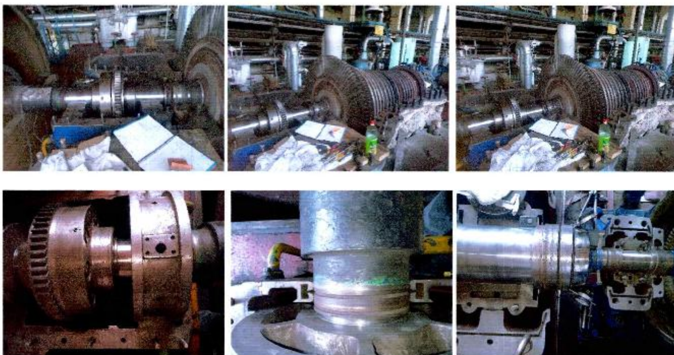
7. Турбины 1,2-р холхивчууд, генераторын роторын 3,4-р холхивчуудын тохируулж блокуудыг хаахын өмнөх байдал.
