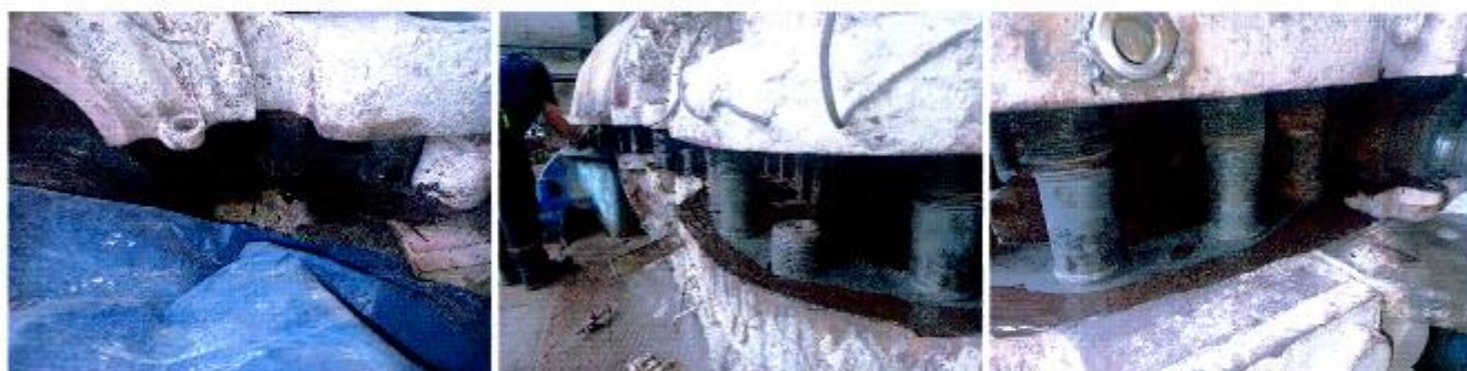
14. Турбины дээд цилиндрийг өргөж доод цилиндрийг агаараар үлээлгэж цэвэрлэн крышка хаах ажлуудыг технологийн дагуу хийж MFZ-3 маркийн мастыкыг түрхэж крышкийг эцсийн байдлаар хаах үеийн байдал.
