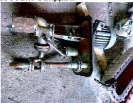
18. Тос хөргөгч болон тосны цахилгаан насосын байдал.
