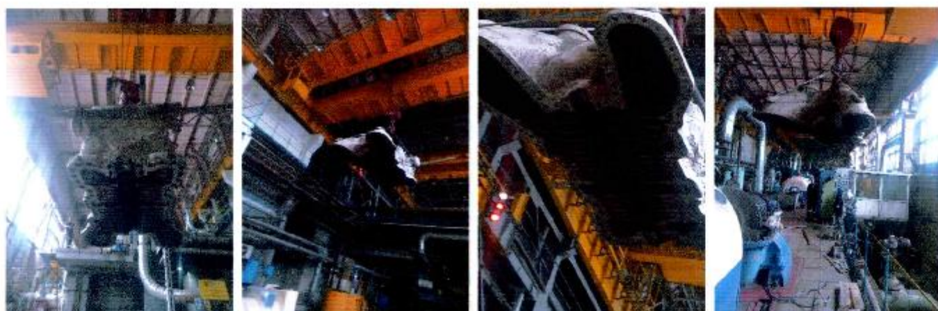
14. Турбины дээд цилиндрийг өргөж доод цилиндрийг агаараар үлээлгэж цэвэрлэн крышка хаах ажлуудыг технологийн дагуу хийж MFZ-3 маркийн мастыкыг түрхэж крышкийг эцсийн байдлаар хаах үеийн байдал.
